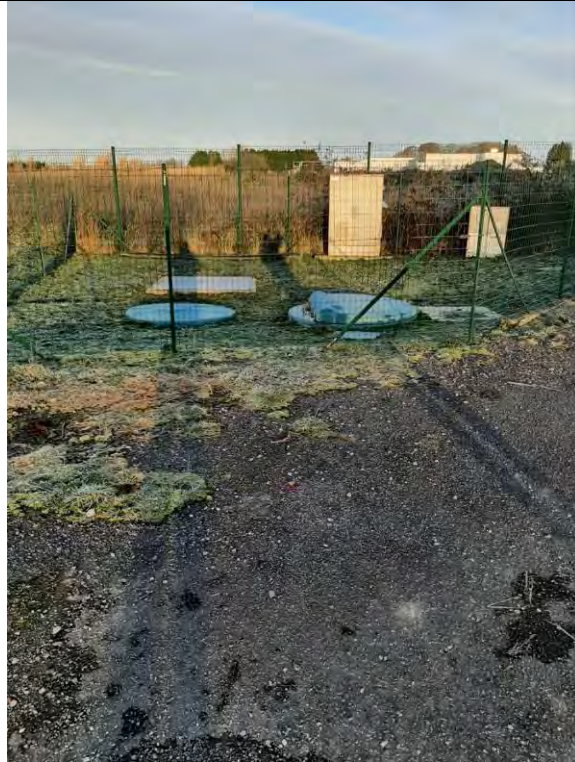
Point 2 : Sud du site
